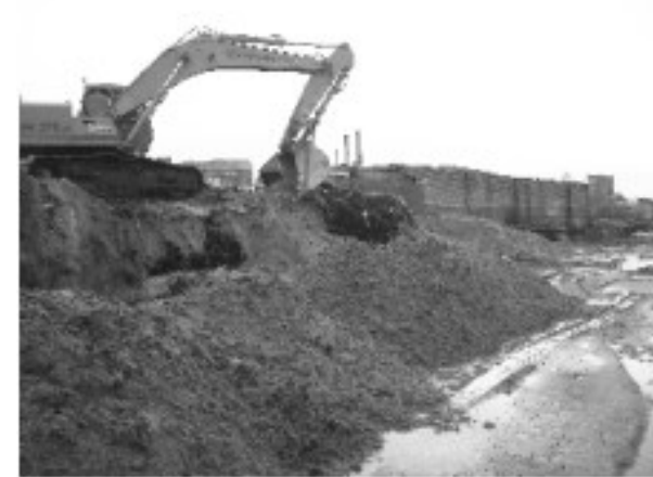
Работы в котловане БФ №3 НЦБК
